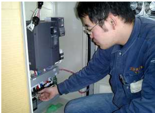
複雑な電気回線をお客様にとって使いやすく、安全かつ見た目も美しく、効率的に配線するのが腕の見せ所です
